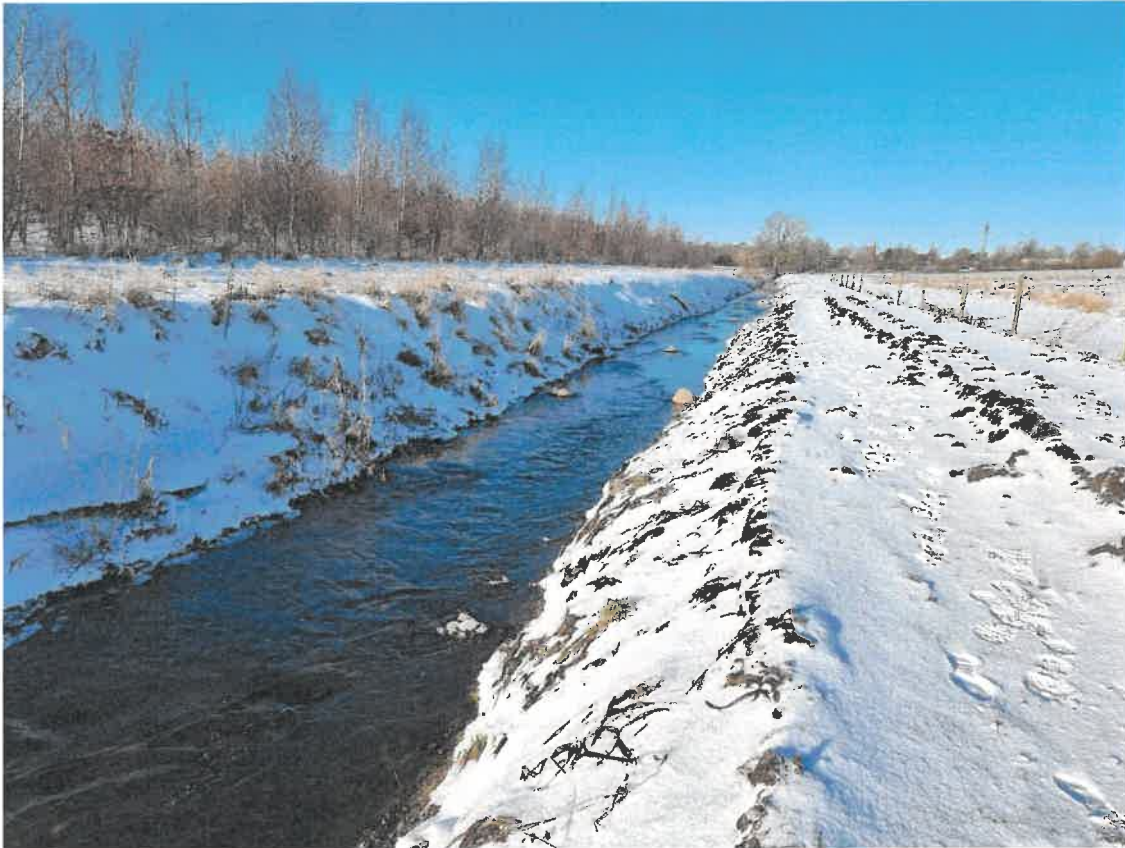
Roskilde Kommune restaurerede strækning 8400-9350 i efteråret 2023
